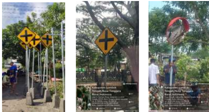
Gambar 3.20 Pemasangan Rambu Lalu Lintas dan Cermin Tikungan di Kecamatan Praya dan Praya Tengah
