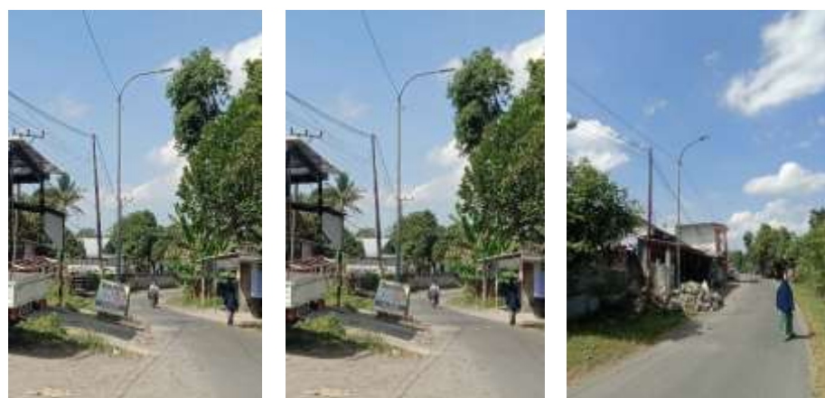
Gambar 3.21 Pemasangan PDU Tenaga Listrik di Kecamatan Praya Tengah
