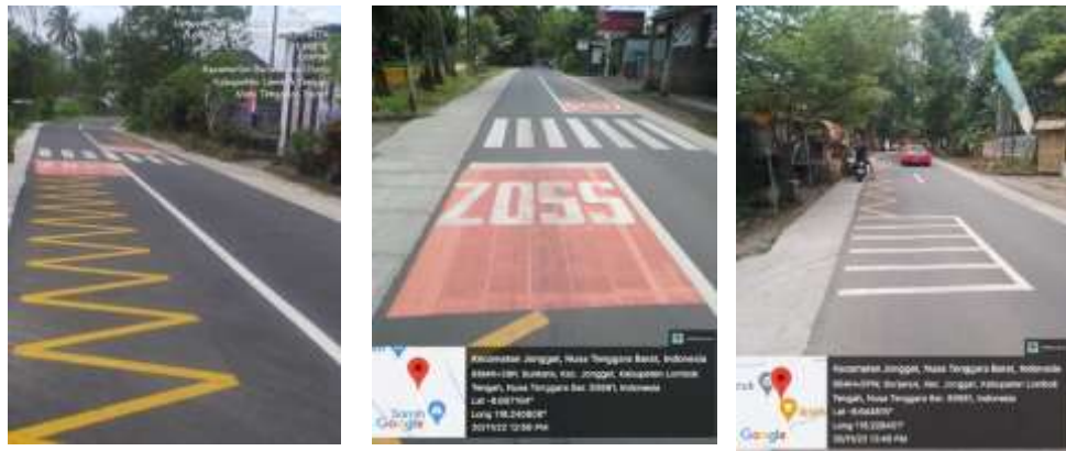
Gambar 3.15 Pembangunan Marka Jalan dan ZoSS
