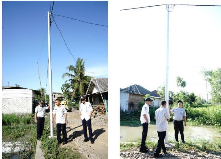
Gambar 3.16 Pemasangan Tiang PDU Galvanis di Desa Beraim Kecamatan Praya Tengah
