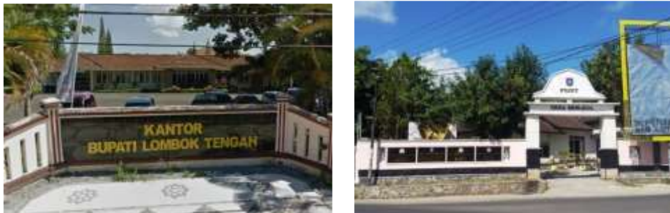
Gambar 2. 6 Daerah Pekantoran di Kabupaten Lombok Tengah
