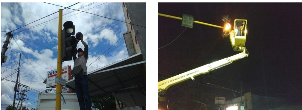
Gambar 3.14 Kegiatan Pemeliharaan Traffic Light dan PJU
