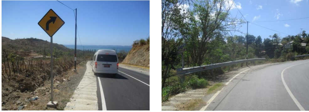
Gambar 3.13 Penyediaan Fasilitas Keselamatan Jalan
