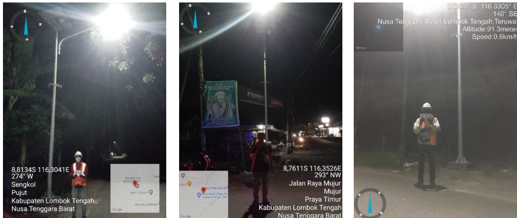
Gambar 3.11 Pemasangan PJU Tenaga Surya (Hibah Kementerian ESDM)
